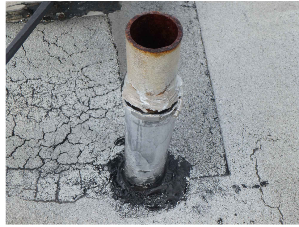
20 Pipe flashing typ.
